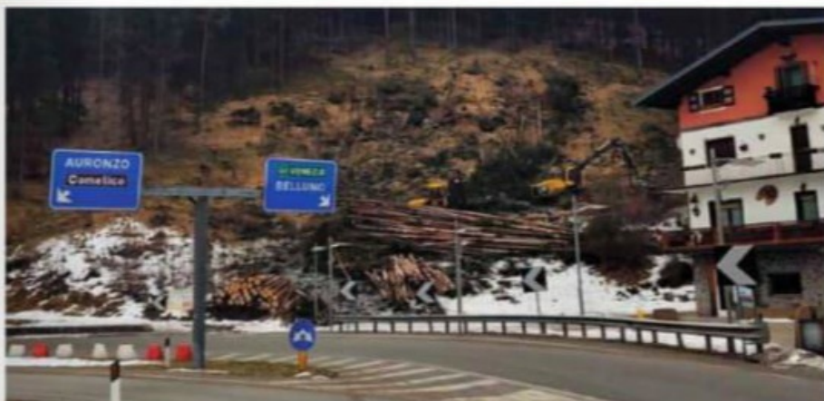
TAI - Lo svincolo sulla Strada statale 51 di Alemagna dove sono iniziati i lavori di esbosco. (Foto Carla Laguna)
